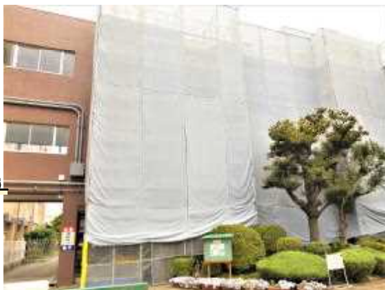
工事中の1号棟
